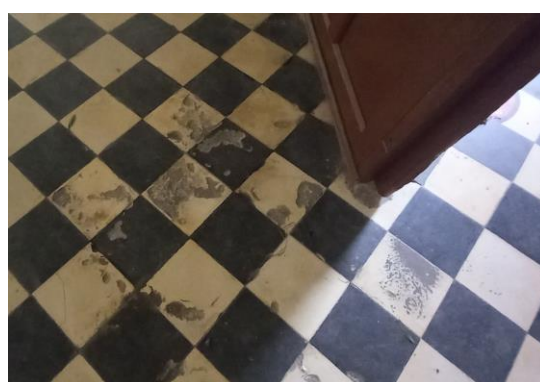
DETALLES DEL MAL ESTADO DEL SUELO ANTERIOR
