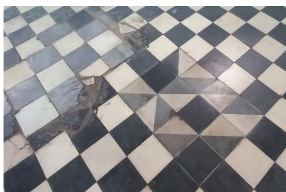
DETALLES DEL MAL ESTADO DEL SUELO ANTERIOR
